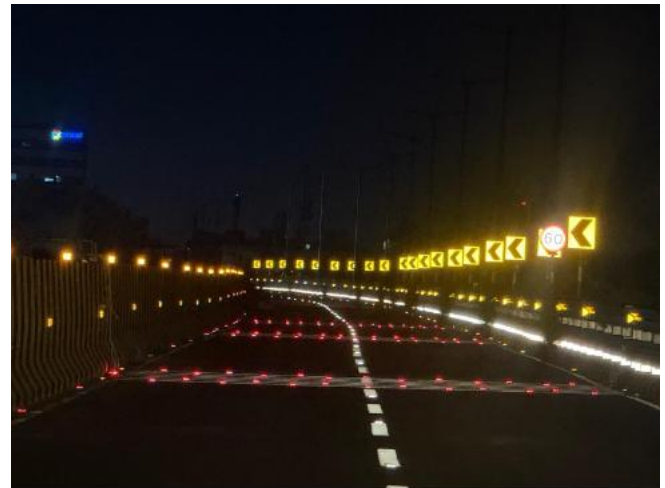
Fig 27. Reflective Road studs
