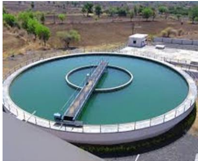
Fig.4. Clariflocculator
