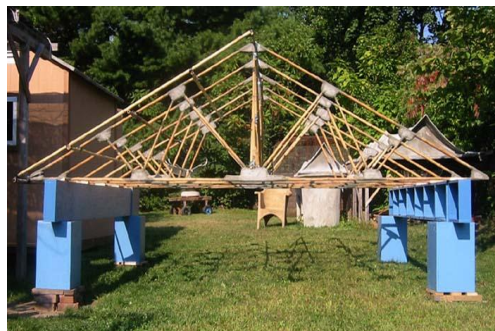
Fig. 9. Bamboo Truss
