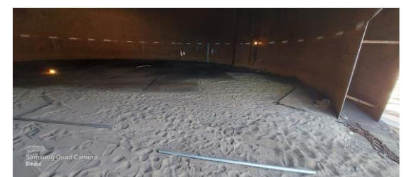
Fig 11. Bottom sand layer 50 mm
